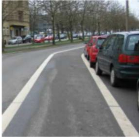
7. Längsmängel, die für die gesamte Strecke gelten (z.B. Sicherheitstrennstreifen zum Schutz vor aufschlagenden Türen fehlt)
